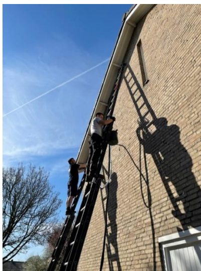
Volgens patroon worden gaten in de muur geboord.
