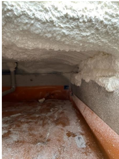
Bodem- en vloerisolatie, ca 10cm pur
